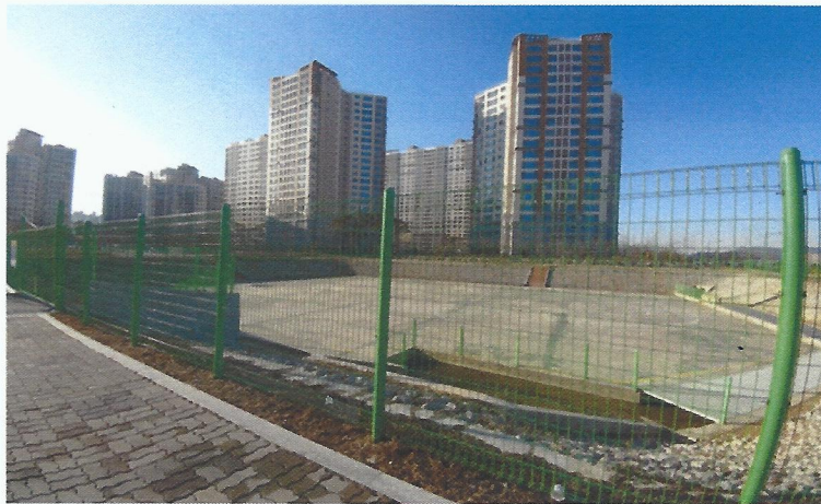
아산시 모종 풍기 유수지 사진
